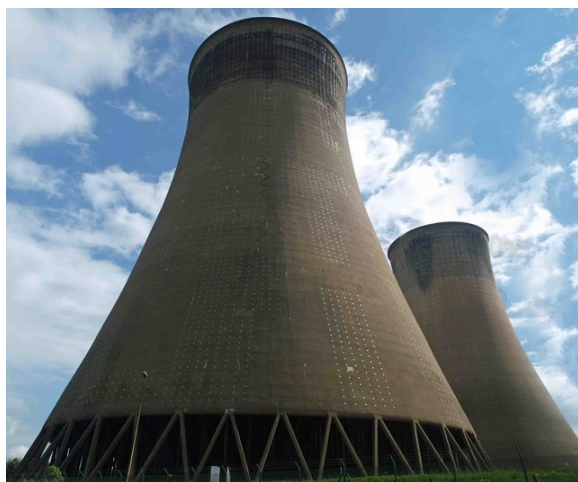
FIGURE 9.9 – Cheminées de refroidissement de la centrale à charbon d’Eggborough (1967, 1960 MW) au Royaume-Uni. Dans ces cheminées, la chaleur prélevée à l’eau du circuit dans le condenseur est évacuée dans l’atmosphère. Ce refroidissement est effectué au moyen d’un circuit d’eau secondaire, qui est mis en contact avec l’atmosphère et s’y évapore partiellement.
