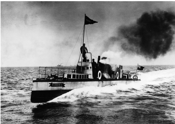
FIGURE 9.23 – Le Turbinia , yacht de Charles Parsons servant de démonstrateur pour ses recherches en propulsion maritime. Avec ses trois turbines à vapeur et ses neuf hélices, il atteint 60 km/h et permet à son propriétaire de ridiculiser la Royal Navy pendant le défilé du jubilé de la reine Victoria en 1897.
