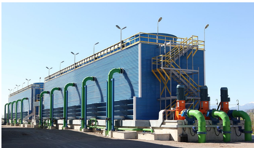
FIGURE 9.8 – Un condenseur dans lequel la chaleur est évacuée directement dans l’atmosphère, par conduction forcée à l’aide de ventilateurs.
