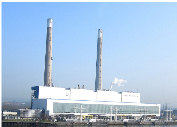
FIGURE 9.27 – Centrale électrique de Porcheville, alimentée au charbon jusqu'en 1987 puis au fioul jusqu'à sa fermeture en 2017. Elle servait principalement les demandes de pointe.
