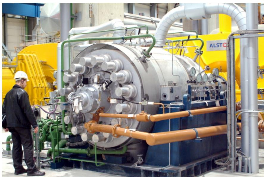
FIGURE 9.2 – Une pompe du fabricant KSB menant 2500 t/h d'eau à 350 bar dans une centrale à vapeur. Les pompes à liquide sont usuellement alimentées par un moteur électrique, mais ce modèle est alimenté mécaniquement par la turbine et doit ainsi fonctionner sur une plus grande plage de vitesses. Sa puissance maximale est de 38 MW ; la puissance de la turbine entraînée dépasse 800 MW.
