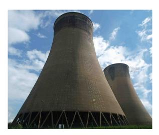
FIGURE 9.9 – Cheminées de refroidissement de la centrale à charbon d'Eggborough (1967, 1960 MW) au Royaume-Uni. Dans ces cheminées, la chaleur prélevée à l'eau du circuit dans le condenseur est évacuée dans l'atmosphère. Ce refroidissement est effectué au moyen d'un circuit d'eau secondaire, qui est mis en contact avec l'atmosphère et s'y évapore partiellement.
