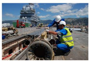
FIGURE 5.33 – Piston d'une catapulte à vapeur du porteavions *Charles de Gaulle.* Photo CC-by-sa par Jean-Michel Roche, Netmarine.net
