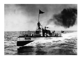
FIGURE 9.23 – Le *Turbinia*, yatch de Charles Parsons servant de démonstrateur pour ses recherches en propulsion maritime. Avec ses trois turbines à vapeur et ses neuf hélices, il atteint 60 km/h et permet à son propriétaire de ridiculiser la *Royal Navy* pendant le défilé du jubilé de la reine Victoria en 1897.
