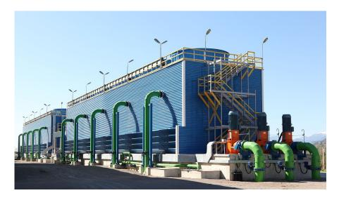
FIGURE 9.8 – Un condenseur dans lequel la chaleur est évacuée directement dans l'atmosphère, par conduction forcée à l'aide de ventilateurs.
