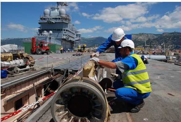
FIGURE 5.33 – Piston d'une catapulte à vapeur du porte-avions Charles de Gaulle. Photo CC-BY-SA par Jean-Michel Roche, Netmarine.net
