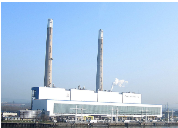
FIGURE 9.27 – Centrale électrique de Porcheville, alimentée au charbon jusqu'en 1987 puis au fioul jusqu'à sa fermeture en 2017. Elle servait principalement les demandes de pointe.
